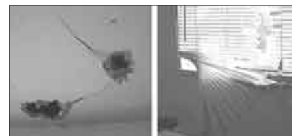
Unikátní díra ve stropě (vlevo) a jedinečným způsobem rozbité okno a poškozený parapet – o obě se postaraly meteority z meteoritického deště v chicagském Park Forestu
